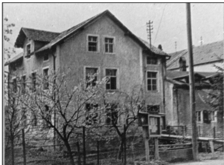
Das Schulhaus von 1883 gleich neben den Ökonomiegebäuden konnte nur über eine kleine Brücke über die Pfatter erreicht werden
