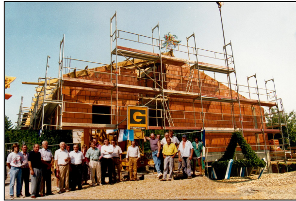
Der Erweiterungsbau beim Richtfest 1993
