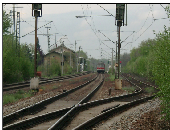
Gleis und Weichenanlagen bei Köfering
