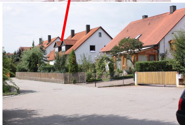
Baugebiet Weiherbreite BA (Bauabschnitt) I.
